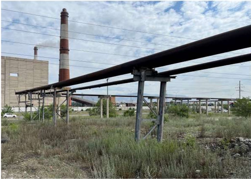
Фото 7, 8 – Поврежденные стальные опоры золошлакопровода
